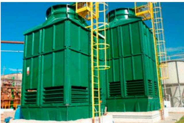
Uma torre de resfriamento ou torre de arrefecimento é um dispositivo de remoção de calor usado para transferir calor residual de processo para a atmosfera.
