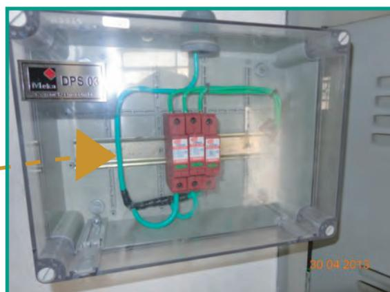
Exemplo de DPS instalados junto ao quadro de alimentação geral de elevadores.
