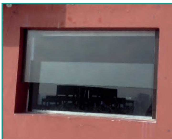
Janelas de ventilação com vidros sobrepostos de forma a manter o arrefecimento do local, mas que promove simultaneamente, uma barreira contra a entrada de água da chuva para o interior do local.
