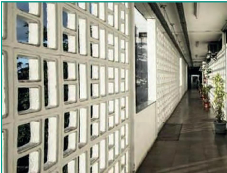
Ventilação natural via elementos vazados.
